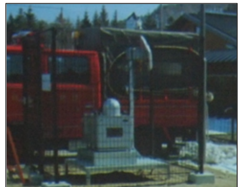
除染し、土を入れ替え、鉄板を敷かれたモニタリングポスト。30m離れると数値は倍。
