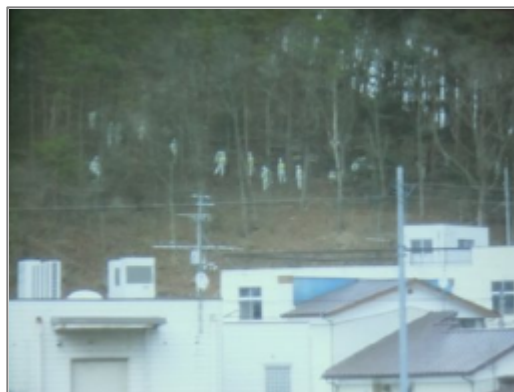
モデル事業で、白い防護服を着た大成建設の スタッフが林の中を除染しているところ
