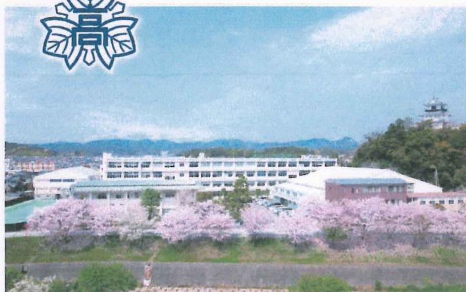
掛川西高の校舎
